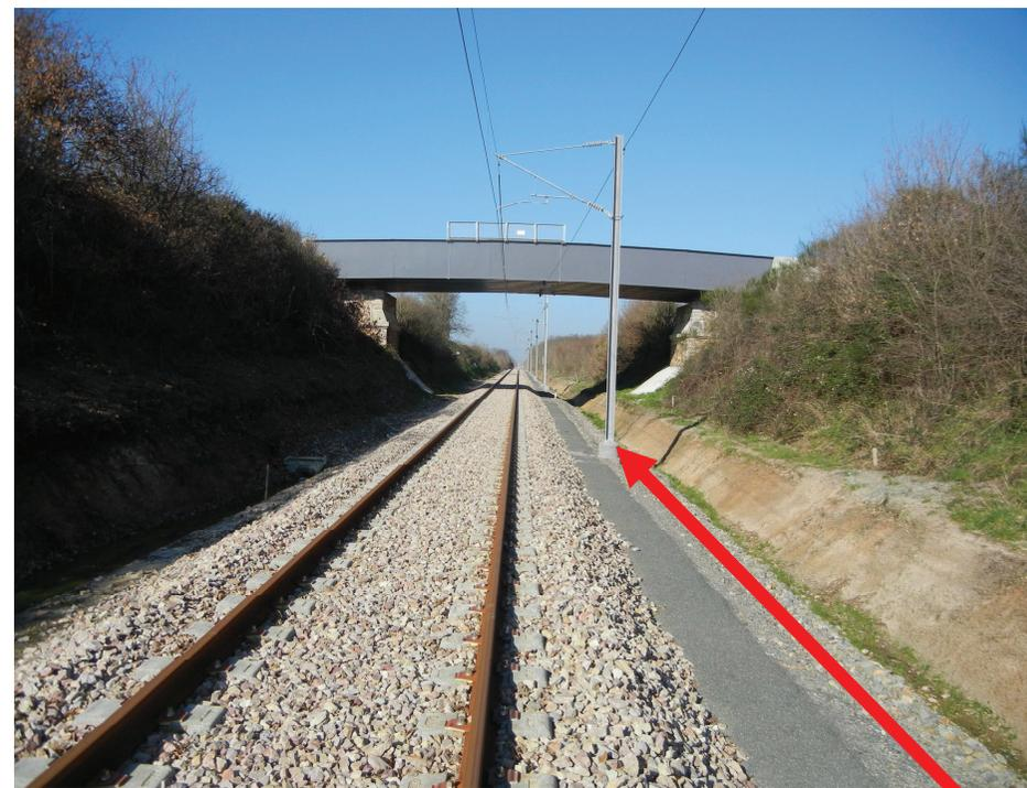
Les poteaux supportant les caténaires sont implantés sur l'axe qui permettrait pourtant d'installer une seconde voie, si **un besoin dans le futur\* ?**
